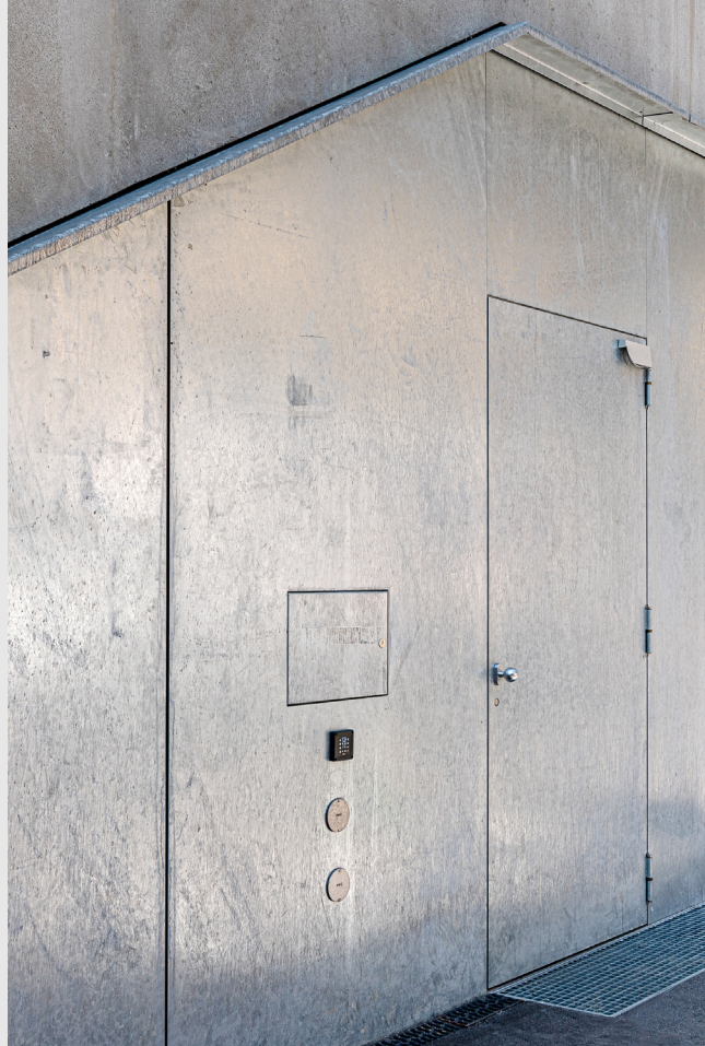
Ensemble résidentiel et commercial Zollhaus Zurich, Suisse forster unico – porte extérieure à isolation thermique en exécution entièrement tôle comme entrée secondaire Photo : Forster Systèmes de profilés SA
